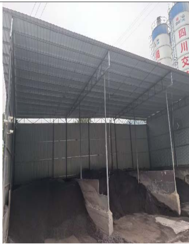
三面围挡及加盖顶棚
