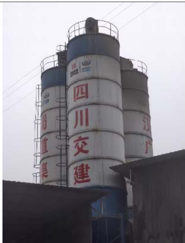
封闭厂房、粉料筒仓布袋除尘器
