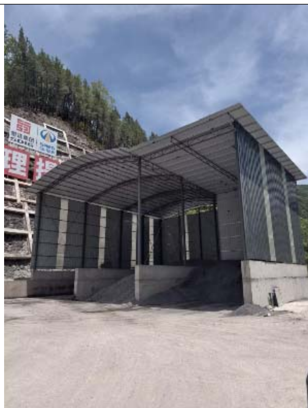
三面围挡及加盖顶棚
