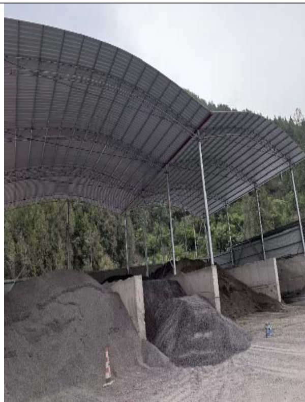
三面围挡及加盖顶棚
